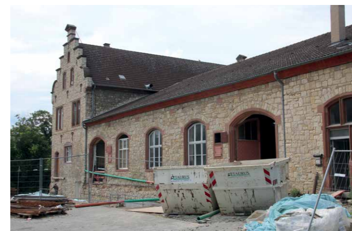
Eine Baustelle von besonderer Bedeutung: der Ingelheimer Winzerkeller. Im Frühsommer 2018 wird er wieder eröffnet.
