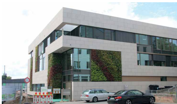
Der Neubau der Mediathek in der Friedrich-Ebert-Straße.
