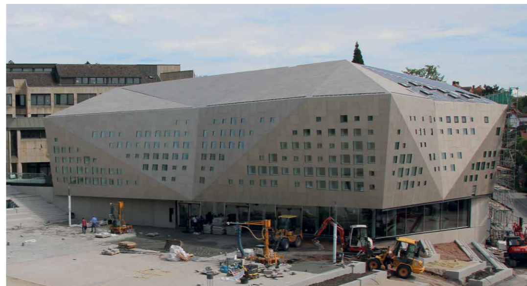
Noch laufen die letzten Arbeiten an der neuen Kultur- und Veranstaltungshalle auf Hochtouren.
